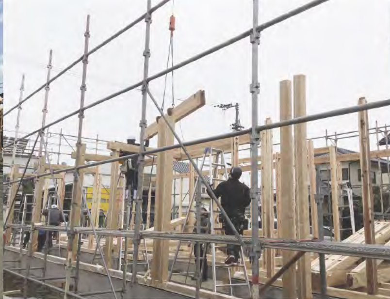
中央に園庭を配したコの字型とし、建物を3棟に分割することで揺れに耐える構造に。建て方は自社大工を中心に平均10名で対応
