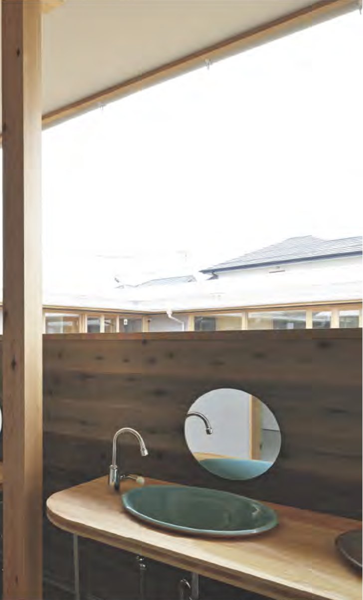
外廊下のスギ板には天然成分を使用した木材防護保持剤を塗布している
