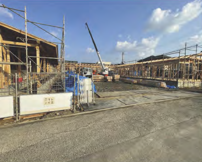
中央に園庭を配したコの字型とし、建物を3棟に分割することで揺れに耐える構造に。建て方は自社大工を中心に平均10名で対応
